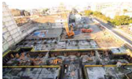
建設中の新外来棟
